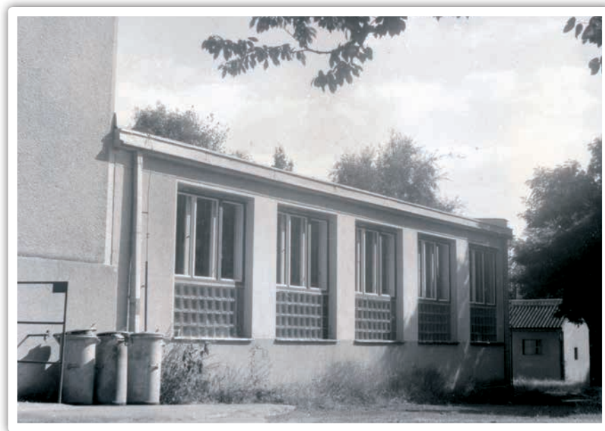
Nová přístavba školy spojující starou budovu s tzv. školičkou
